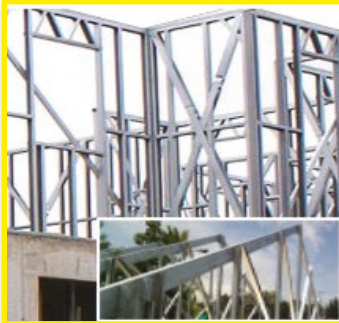
PANELES Y CERCHAS ACERO
